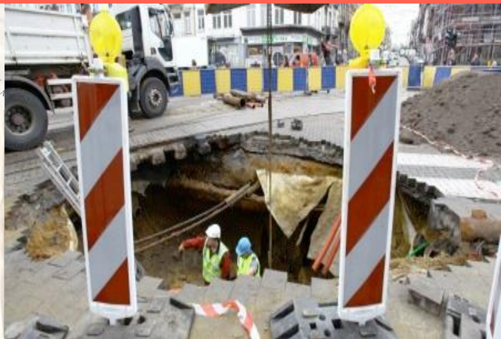
■ De put in de Henri Jaspalaan (l) is de derde grote wegverzakking in 40 dagen tijd. Oorzaak: de abominabele staat van de verouderde riolen.
