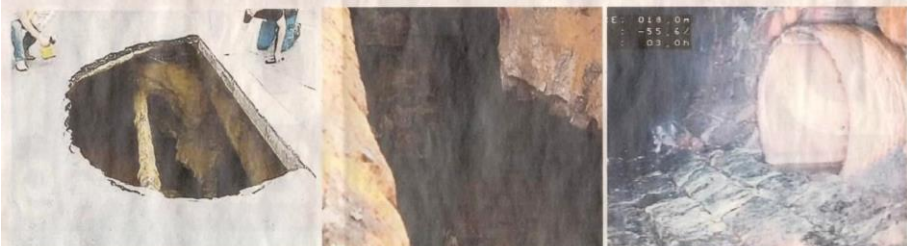
■ De put in de Henri Jaspalaan (l) is de derde grote wegverzakking in 40 dagen tijd. Oorzaak: de abominabele staat van de verouderde riolen.
